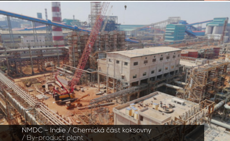
NMDC – Indie / Chemická část koksovny / By-product plant
