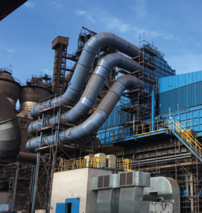
SLOVENSKO – Aglomerace, odprášení rudných mostů / Dedusting of Ore Bridges
