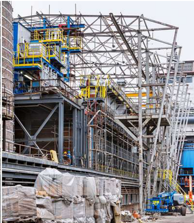
Třinecké železářny - Oprava a modernizace KB 11/ Revamping of Coke Oven Battery no. 11
