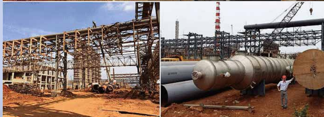
NMDC – Výstavba Chemických provozů koksovarny / Construction of Chemical plant
